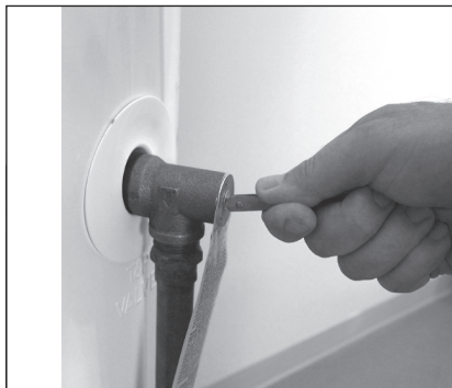
Figura 49 - Válvula de alivio de T y P.
