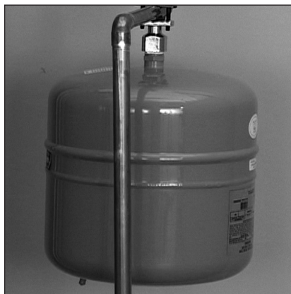
Figura 18 - El tanque de expansión térmica se debe presurizar con aire para que coincida con la presión de agua entrante del hogar.
